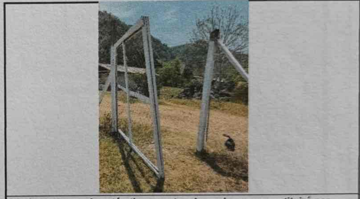
Se observa que el portón tiene postes de madera y se sustituirá por columnas de concreto.
