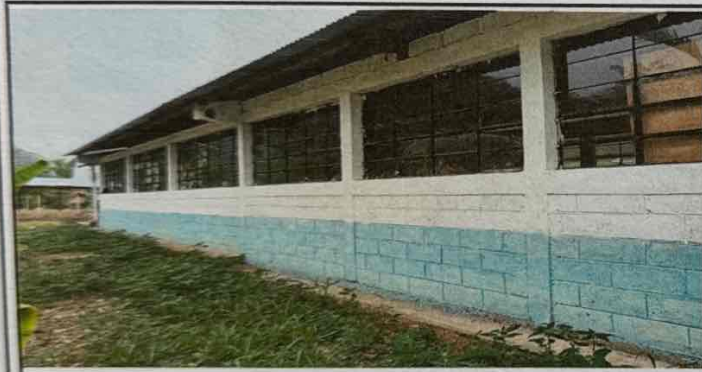
Foto 3: Cambio de pintura por deteriorado por lluvias, exterior.
