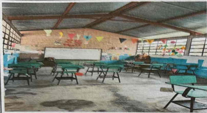
Foto1: Aplicación de pintura interior del aula.
