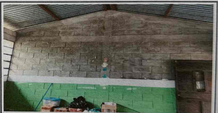
Foto 4: Aplicación de pintura interior del aula.
