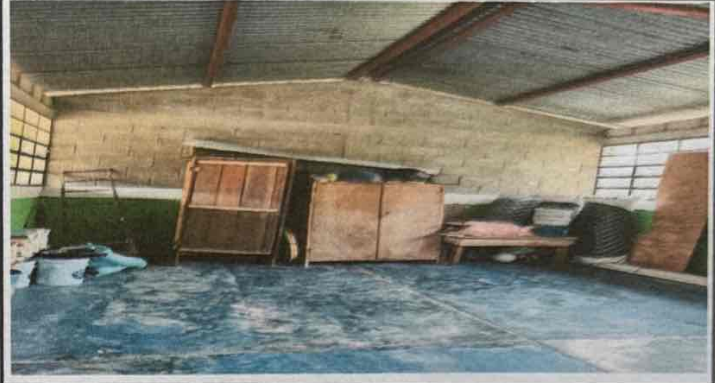
Foto 2: Aplicación de pintura interior del aula.
